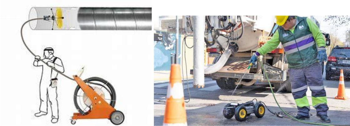
**Figura 51-** Robots de limpieza de conductos o chanchos
