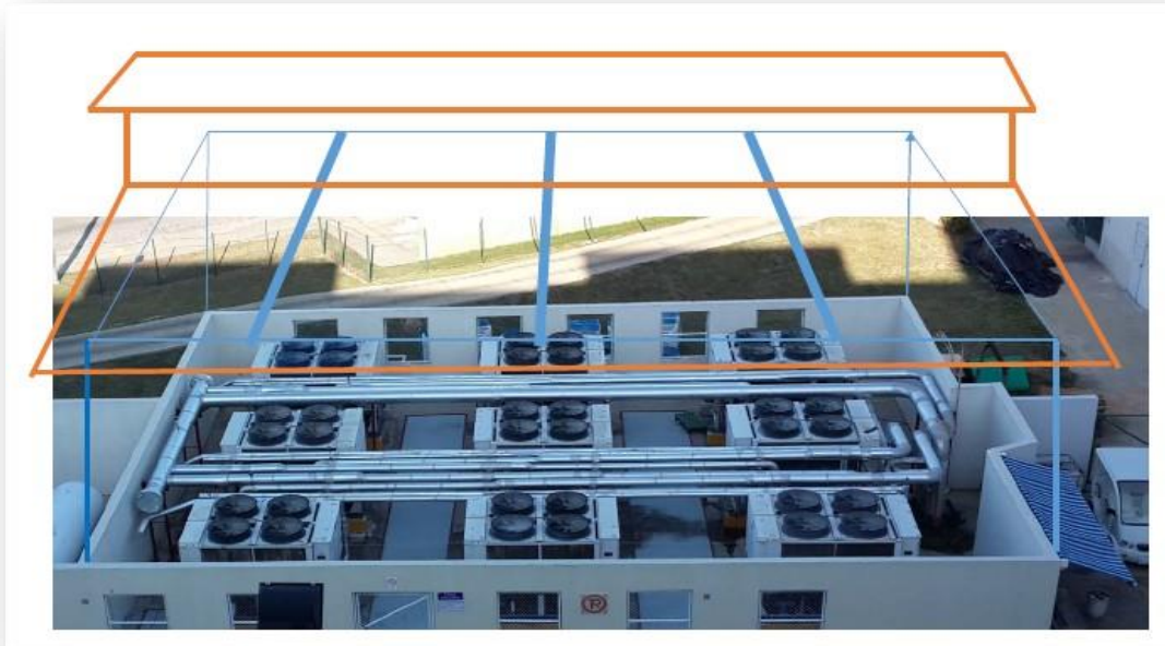
Figura 3. Diseño de la cápsula para las enfriadoras del hotel Meliá Marina
